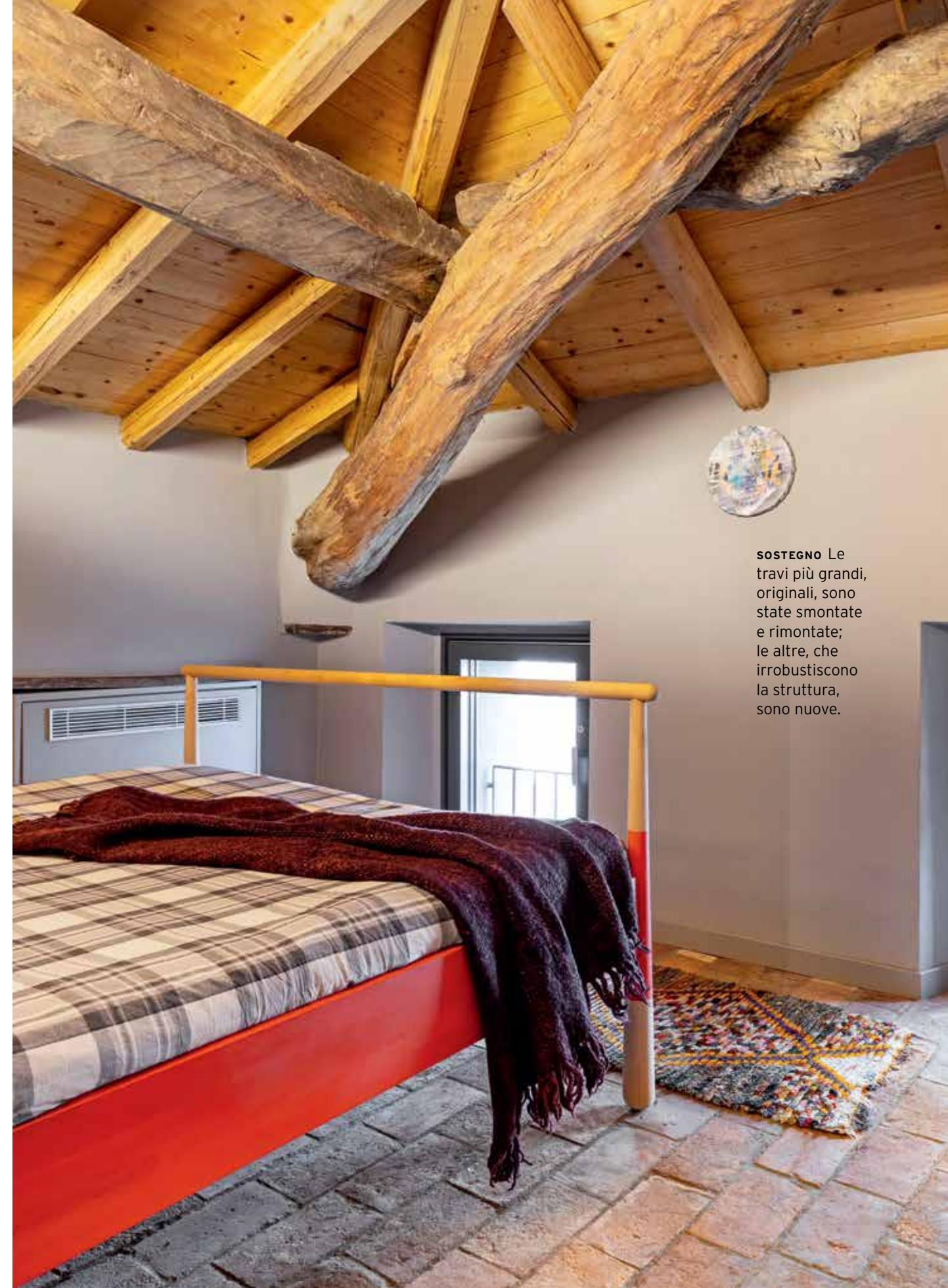
**SOSTEGNO** Le travi più grandi, originali, sono state smontate e rimontate; le altre, che irrobustiscono la struttura, sono nuove.
